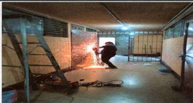
Foto 11: PUERTAS DE METAL SUSTITUCIÓN DE CHAPAS EN 5 PUERTAS.
