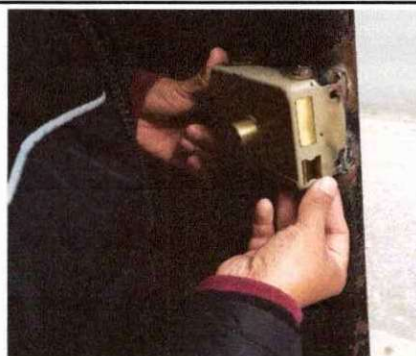
Foto 12: SUSTITUCIÓN DE CHAPA EN 1 PORTÓN DE INGRESO DE LA JORNADA VESPERTINA
