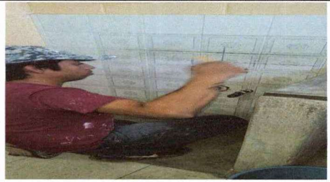
Foto 8 SUSTITUCION DE MINGITORIOS EXISTENTES EN MAL ESTADO POR NUEVOS
