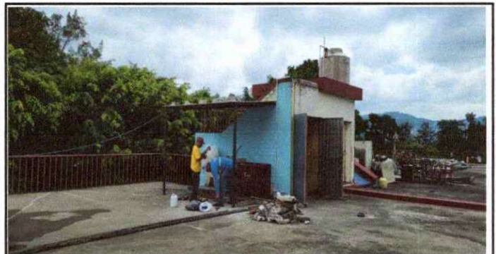
Foto 6: DESMONTAJE DE 3 LAMINAS EN MAL ESTADO Y CAMBIARLAS POR 4 NUEVAS DE 12 PIES.
