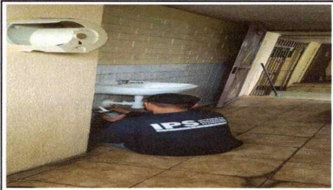
Foto 10: SUSTITUCIÓN DE 10 LAVAMANOS, 10 SIFONES VÁLVULA DE LAVAMANOS, CONTRA LLAVES DE MEDIA A LA PARED, CAMBIO DE LLAVE DE LAVA MANOS, EXISTENTES.
