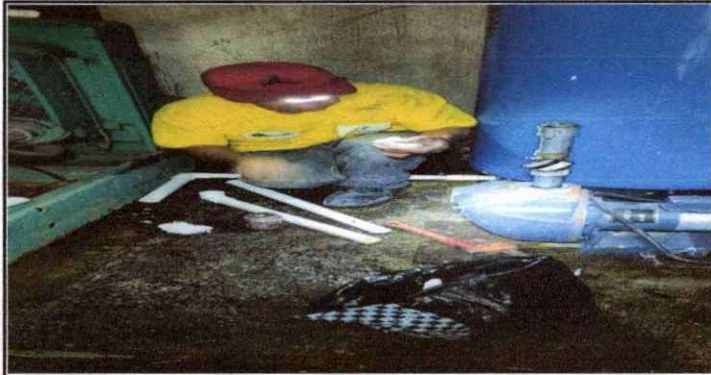
Foto1: SUSTITUCIÓN DE TUBERÍA DE BOMBA. INCLUYE, CONEXIÓN HIDRÁULICA, ELÉCTRICA MATERIALES Y ACCESORIOS NECESARIOS, ACCESORIOS DE PVC Y TUBERÍA
