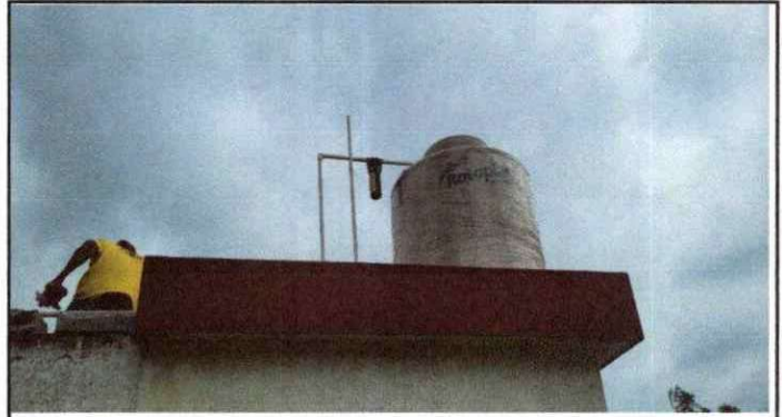
Foto 2: INSTALACIÓN DE 1 DEPÓSITO DE AGUA DE 1100 LITROS MARCA ROTOPLAS.
