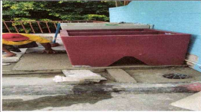
Foto 7: SUSTITUCIÓN DE PILETA DE PISO UBICADA FRENTE A LOS TALLERES DE COCINA POR UNA PILA PLÁSTICA DE UN LAVADERO TALISHE
