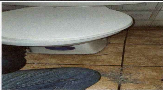
Foto 9: SUSTITUCIÓN DE 8 INODOROS EN MAL ESTADO POR INODOROS NUEVOS.
